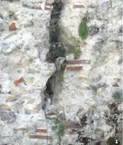
1. Détail de chaînages de briques
